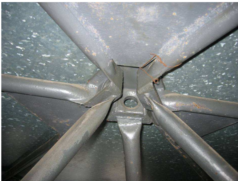
Obr. 6 Spoj horního pásu bez originální styčnickové spojky
