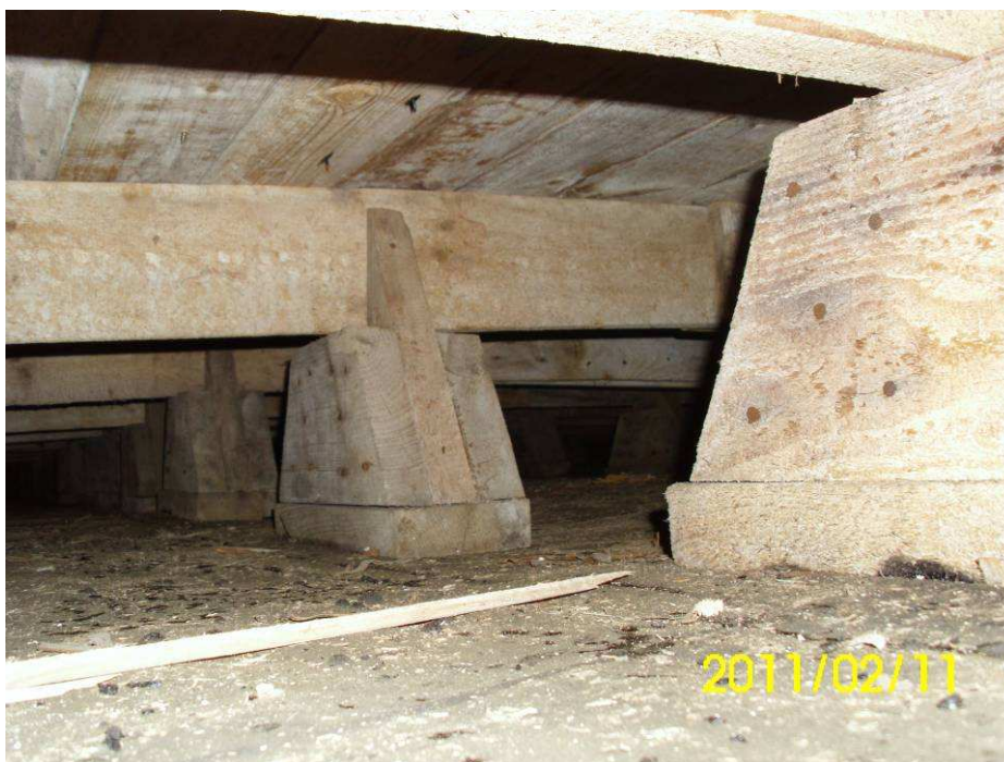
Obr. 8 Detail horního střešního pláště – nosná dřevěná konstrukce bednění
