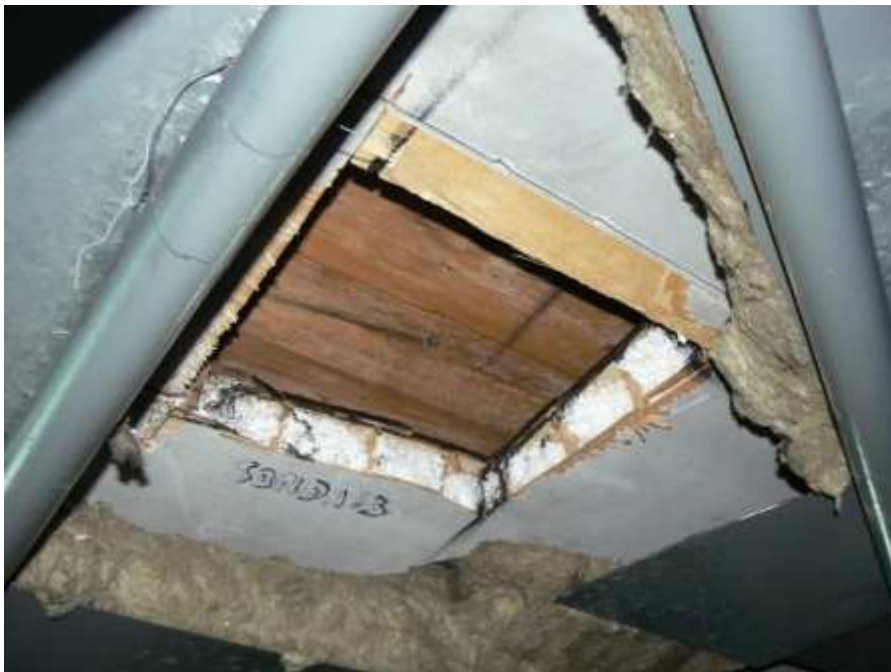
Obr. 7 Detail sondy – otvor v izolačním panelu JRD Nemšová
